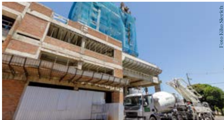
Construção da sede própria e Residencial Omoiru
