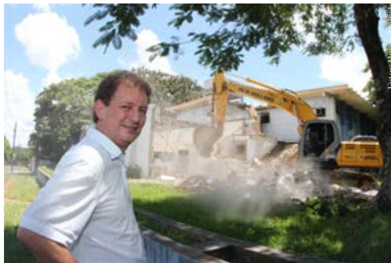
Sede antiga sendo demolida
