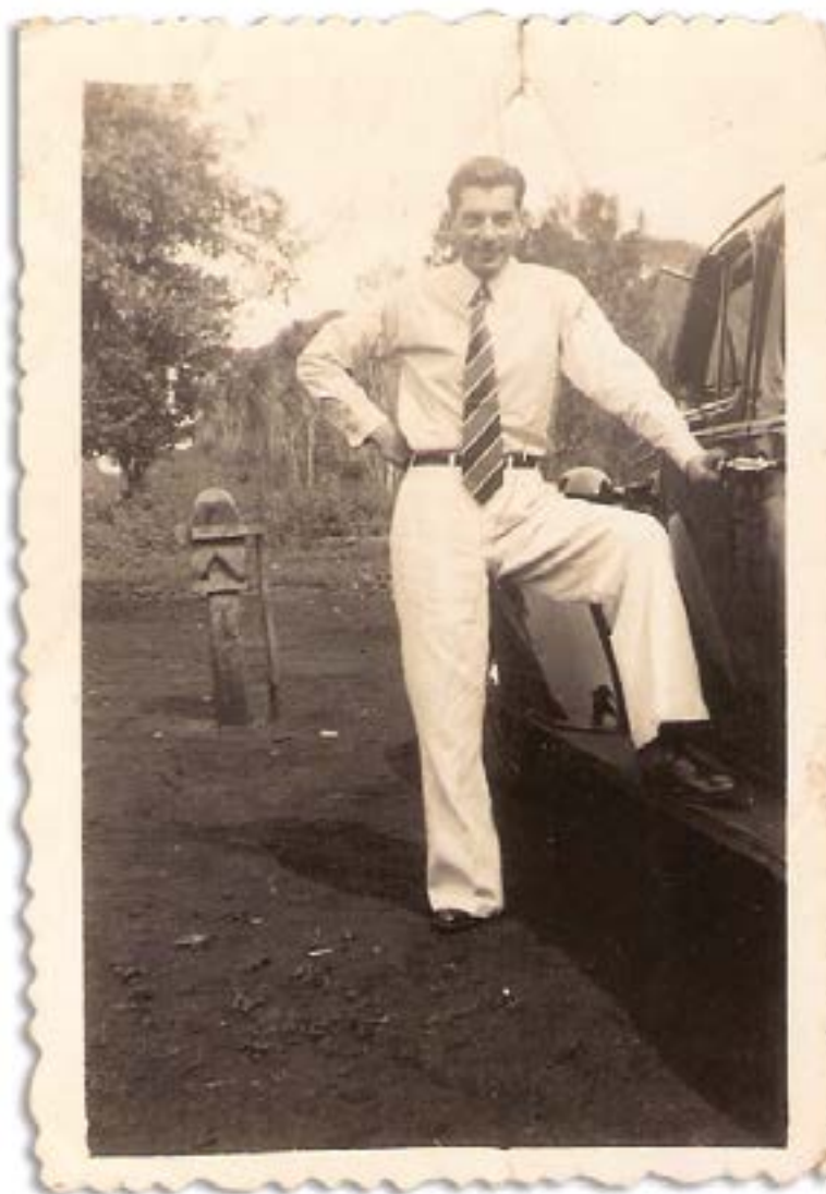
Na construção do calçamento de acesso às Cataratas
